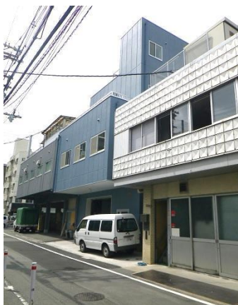
本社工場 大阪府守口市
